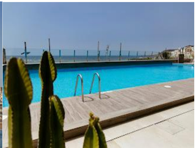
PISCINA CLIMATIZADA 0 279 DEL HOTEL
